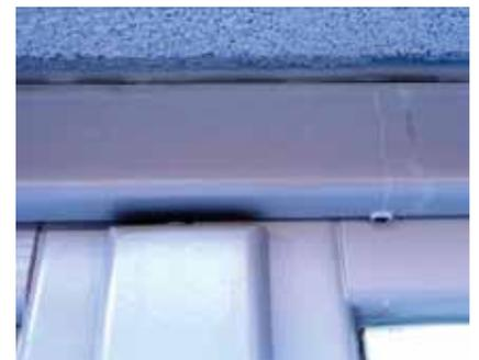
La rottura del cordolo di silicone sia nella parte interna che esterna ha consentito il passaggio di vapore che si è condensato all'esterno della finestra
